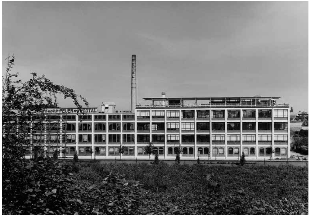
Beim Entwurf der Erweiterung griff Egon Eiermann 1938 die Charakteristika des Bestandes auf, fügte aber moderne Elemente wie die großen Rahmenfenster oder das Flugdach über der Dachterrasse hinzu. © saai | Südwestdeutsches Archiv für Architektur und Ingenieurbau am Karlsruher Institut für Technologie (KIT), Werkarchiv Egon Eiermann, Fotos Eberhard Troeger
