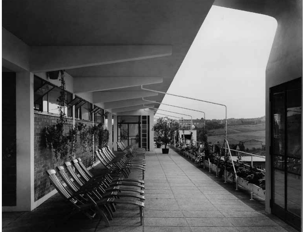
Für die Pause war gesorgt: Dachterrasse mit Liegestühlen über dem großzügigen Speisesaal der Kantine. Foto Eberhard Troeger, © saai | Südwestdeutsches Archiv für Architektur und Ingenieurbau am Karlsruher Institut für Technologie (KIT), Werkarchiv Egon Eiermann, Fotos Eberhard Troeger
